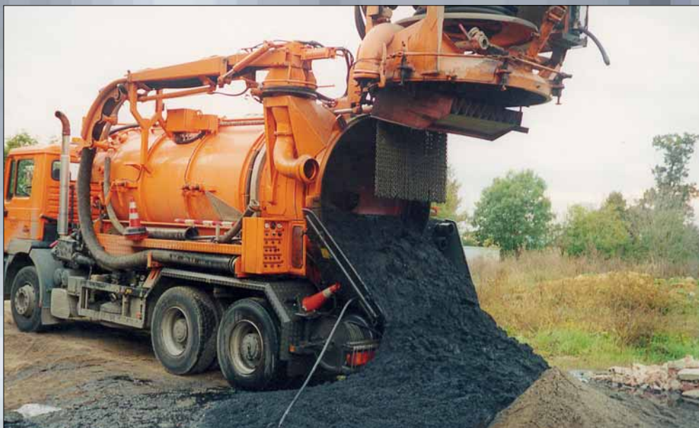
Vyprazdňování kalové komory
