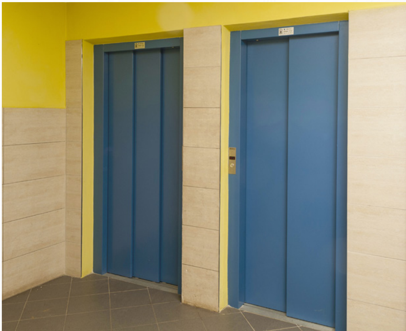
Šachetní dveře teleskopické, provedení tříkřídlé a dvoukřídlé
