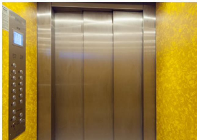
Dveře kabinové teleskopické, nerez broušený
