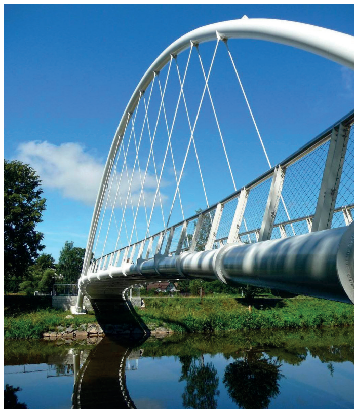
Nová oblouková lávka se zavěšenou mostovkou v Semilech
