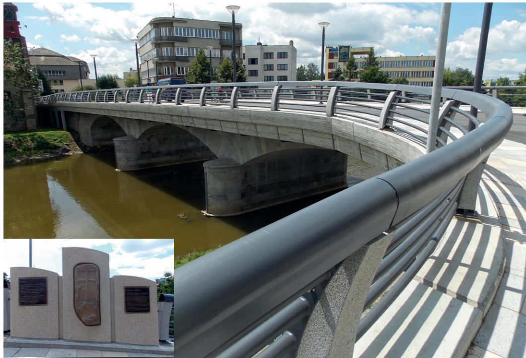
Rekonstrukce mostu v Havlíčkově Brodě, jehož součástí je kulturní památka Hnátův Kámen
