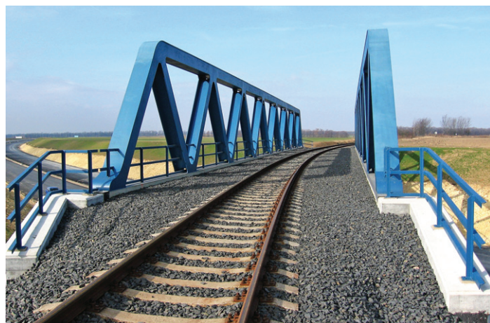
R6 Praha - Pavlov, pohled na most 50 210
